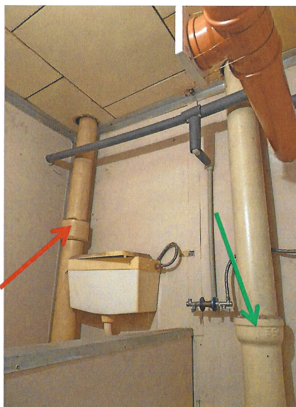
Foto č. 13 - WC pro veřejnost muži. Azbestocementové a litinové potrubí odvětrání kanalizačních stoupaček.
