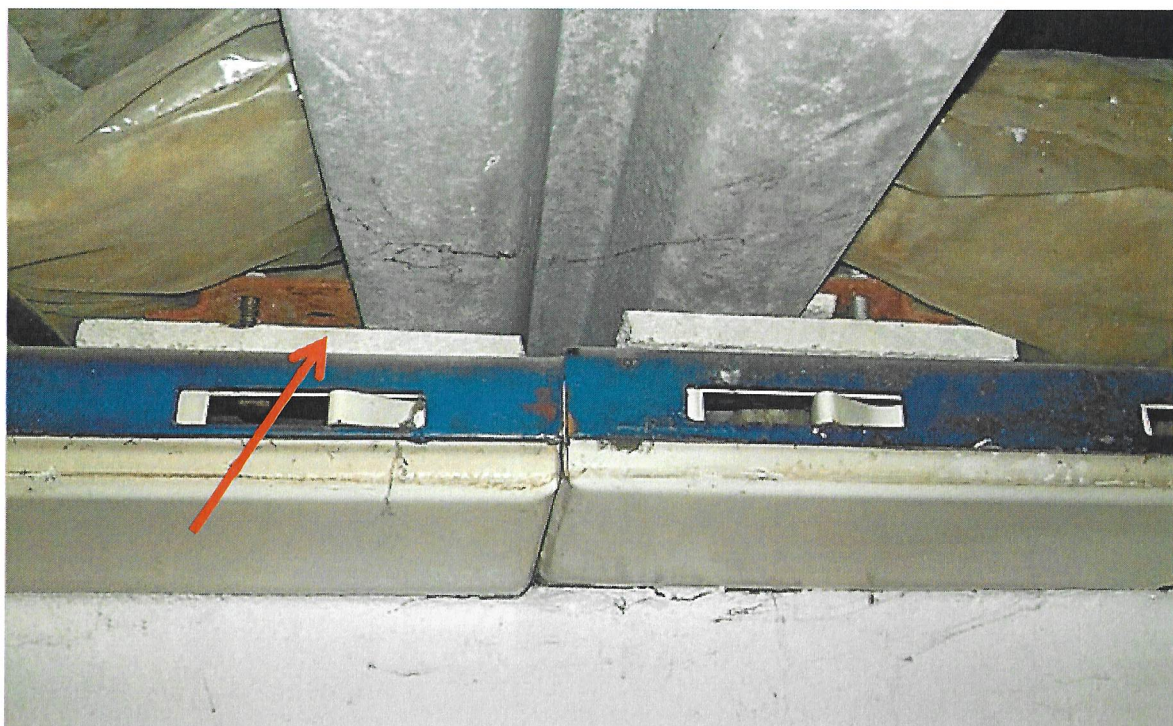
Ilustrační Foto č. 11 (foto pořízeno na jiné zakázce v jiném objektu) – Azbestové distanční podložky v ocelové nosné konstrukci podhledu, resp. stropu a izolační vata v PVC pytlích.
