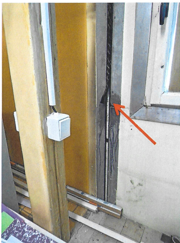
Foto č. 2 – Lokalizace místa odběru vzorku č. 1. Stavědlová ústředna. Azbestocementová konstrukční deska na vnitřní straně obvodového pláště.
