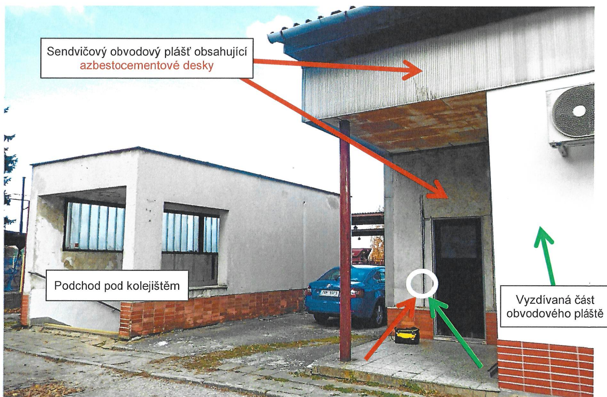
Foto č. 7 – CELEK. Lokalizace místa odběru vzorků č. 4 a 5. Rohová část objektu směrem k podchodu pod kolejištěm.
