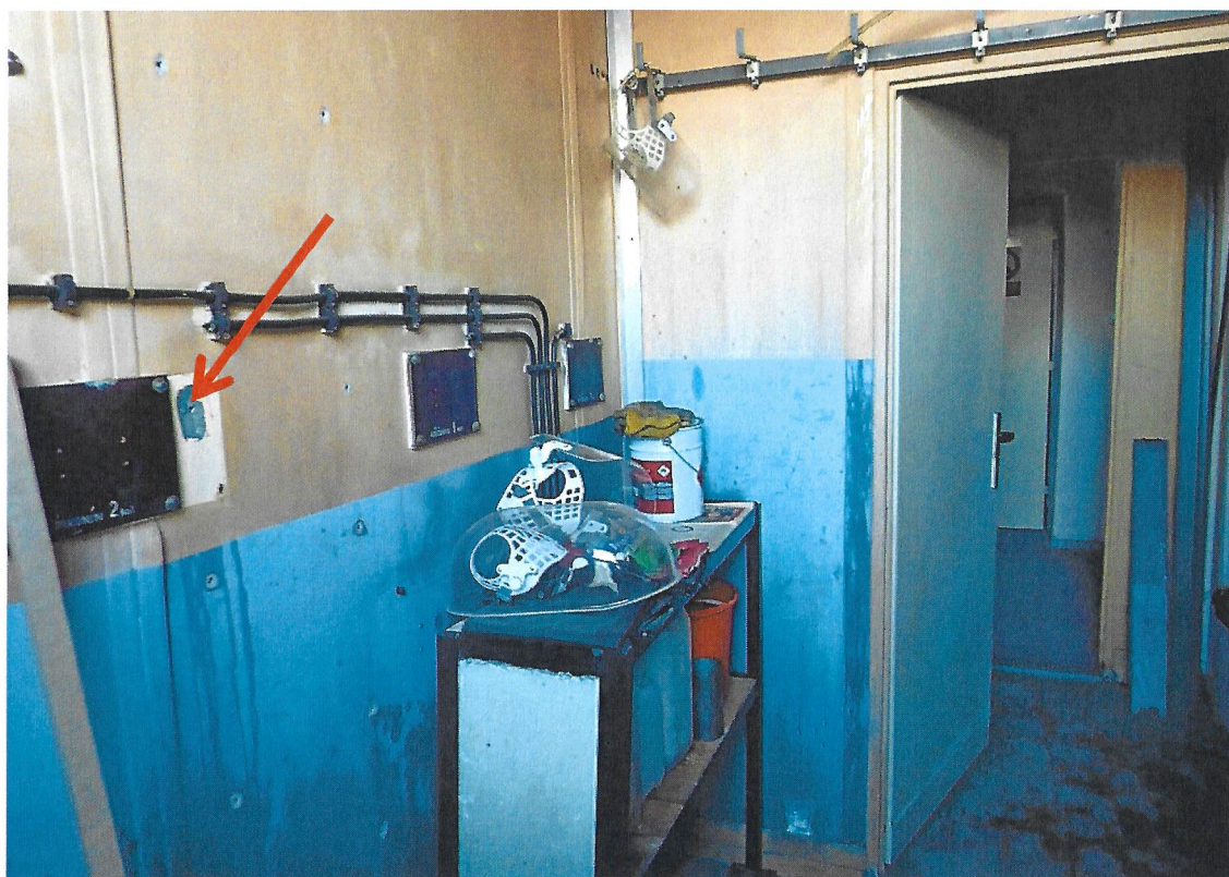
Foto č. 4 – CELEK. Lokalizace místa odběru vzorku č. 2. Akumulátorovna. Azbestocementová konstrukční deska dělicí příčky mezi akumulátorovnou a sdělovací místností.
