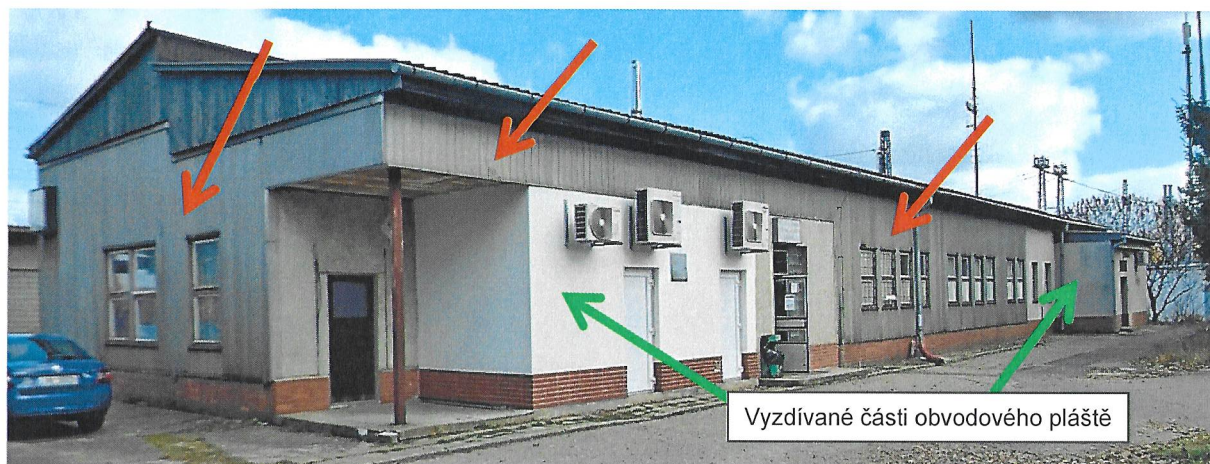
Foto č. 9 – Celkový pohled na výpravní budovu ze strany hlavního vchodu pro veřejnost. Azbestocementové desky v konstrukci obvodového pláště.
